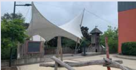
Schoul - rue du 9 mai
